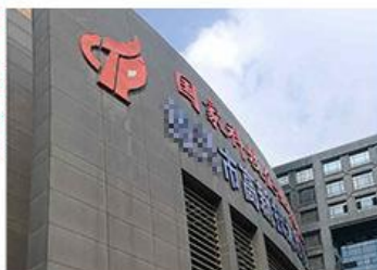
铝塑板外墙翻新
